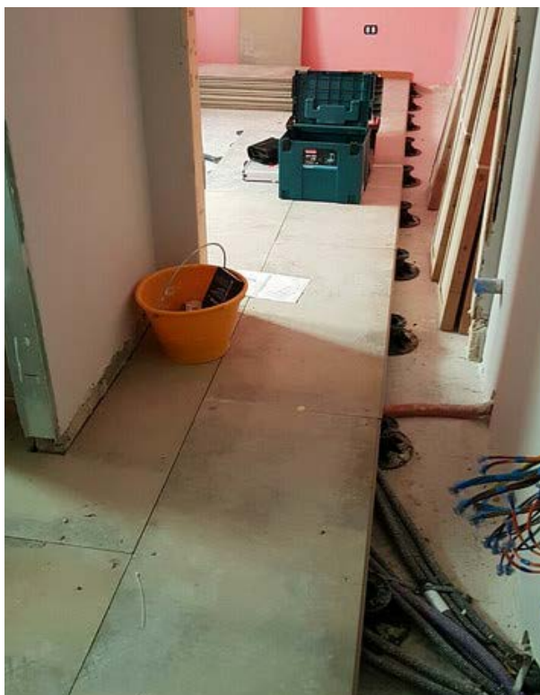
Disposizione giunti sotto battente porta
