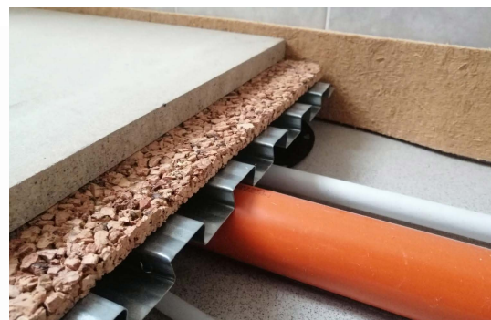
Posa dei supporti livellati a laser e fissati alla base e alla testa con viti e tasselli su BetonWood
